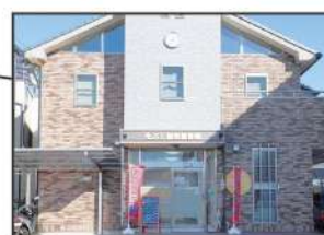
大阪府寝屋川市打上元町11-18
